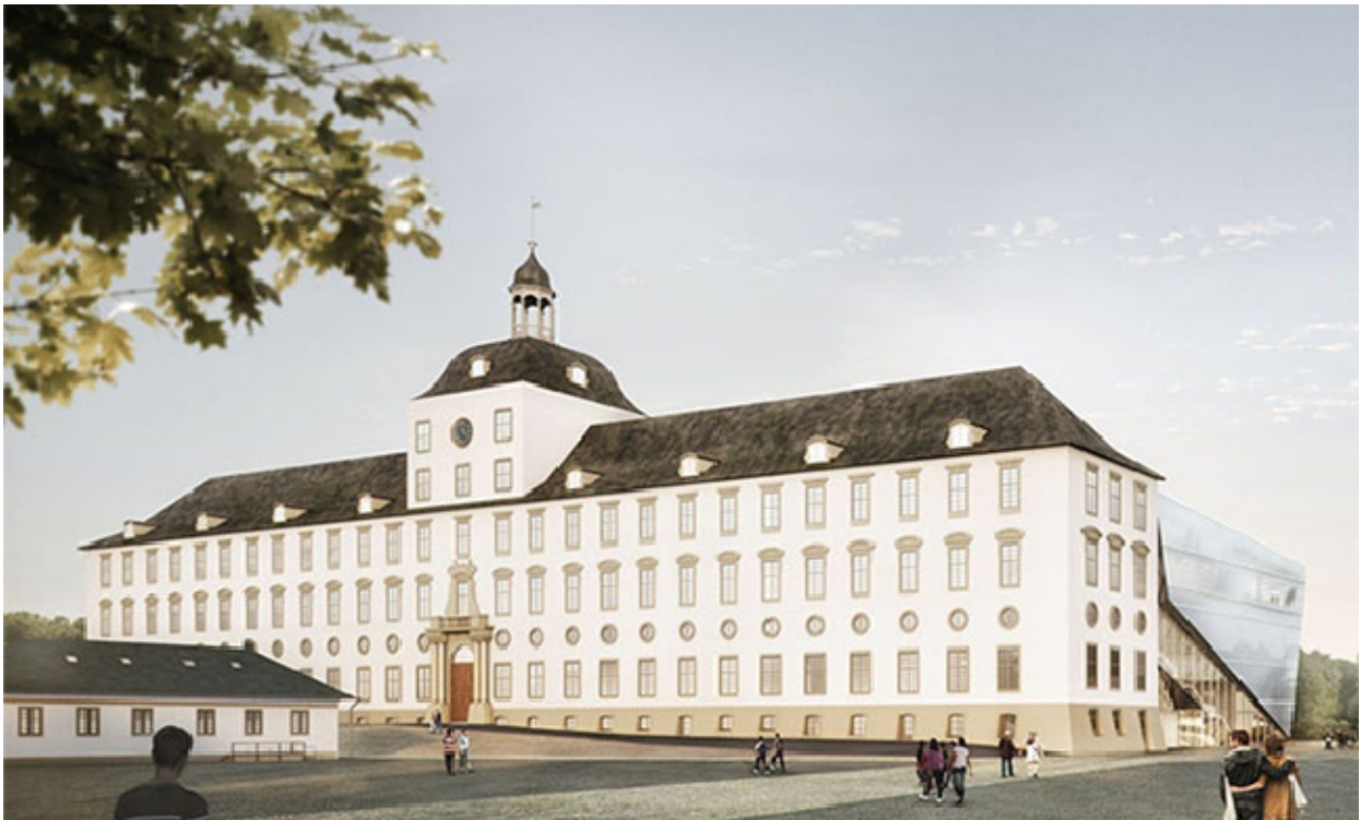
Blick auf die Südfassade © Holzer Kobler Architekturen / Stiftung Schleswig-Holsteinische Landesmuseen
