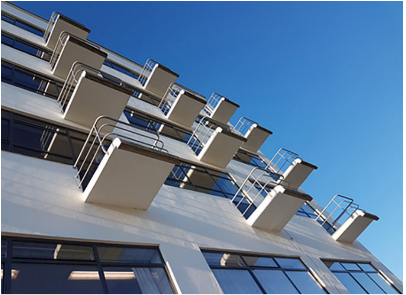
Bauhaus Dessau, Ateliergebäude, Foto: K. Baumann
